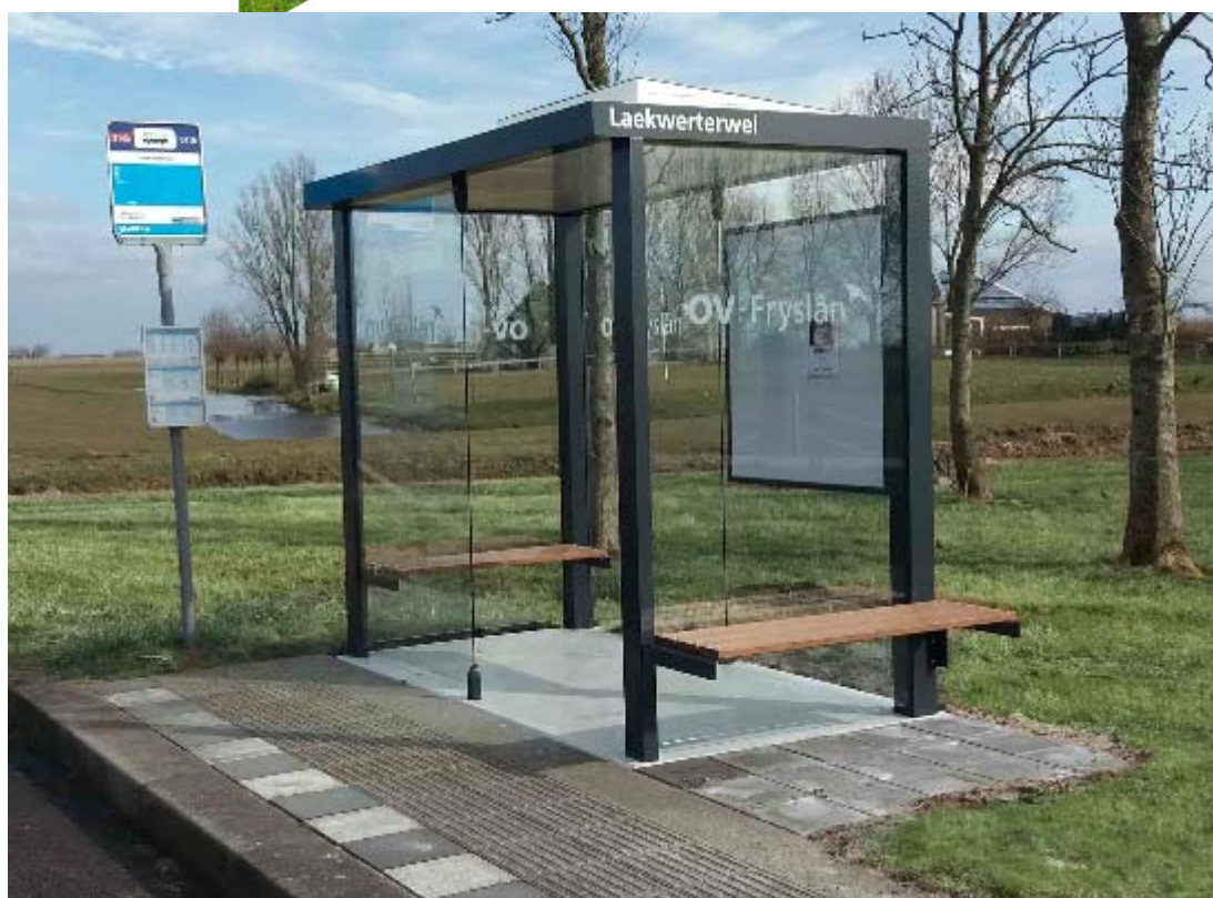
Abri Friesland uitgevoerd met zonnepanelen en LED
